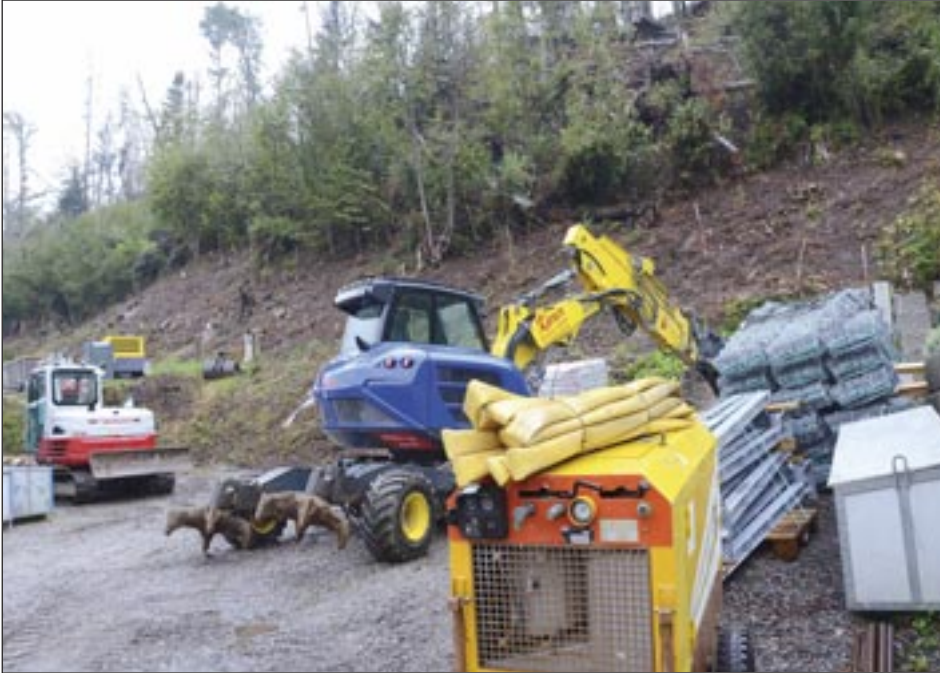
Unterhalb der Hofstelle „Hauser“ wird zur Zeit ein massives Steinschlagnetz errichtet. Der Schutzzaun wird 190 Meter lang und 3 Meter hoch.
